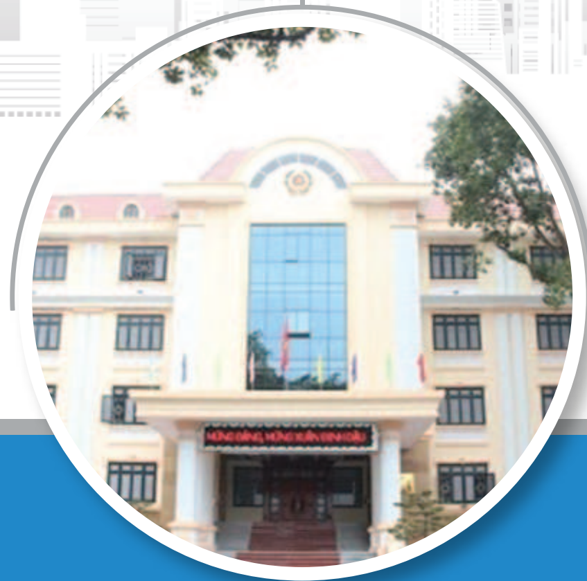
Thi công hệ thống mạng, thoại, truyền hình, thiết bị báo cháy tại UBND huyện Hiệp Hòa
