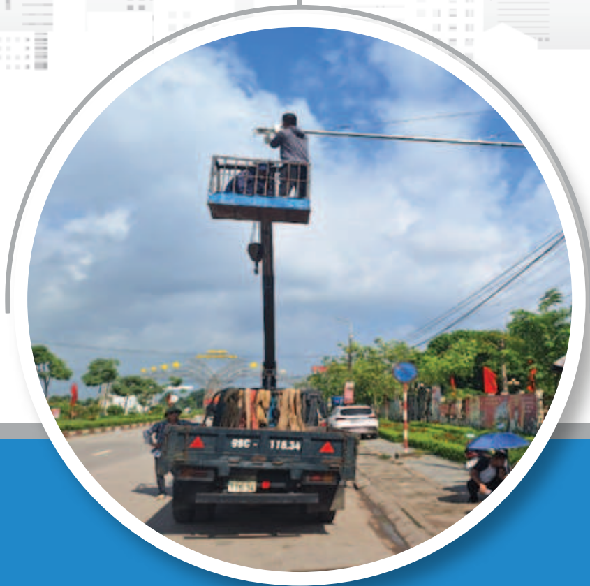
Cung cấp, Lắp đặt hệ thống Camera giám sát an ninh huyện Lạng Giang, tỉnh Bắc Giang
