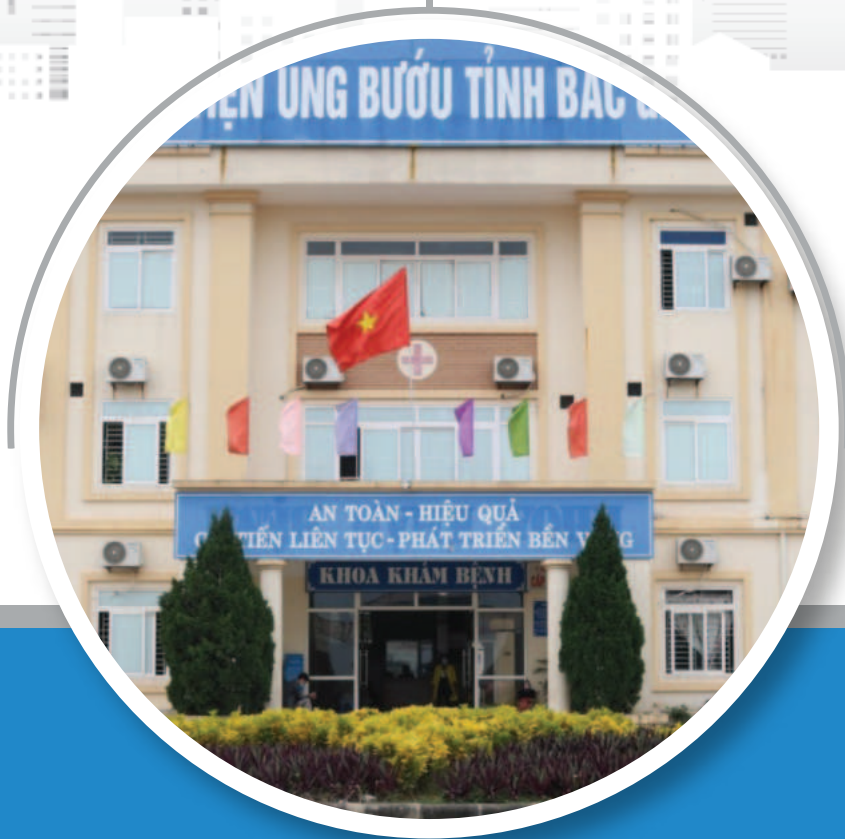
Thi công hệ thống mạng, thoại, truyền hình, nút báo y tá, thiết bị báo cháy tại Bệnh viện Ung Bướu tỉnh Bắc Giang
