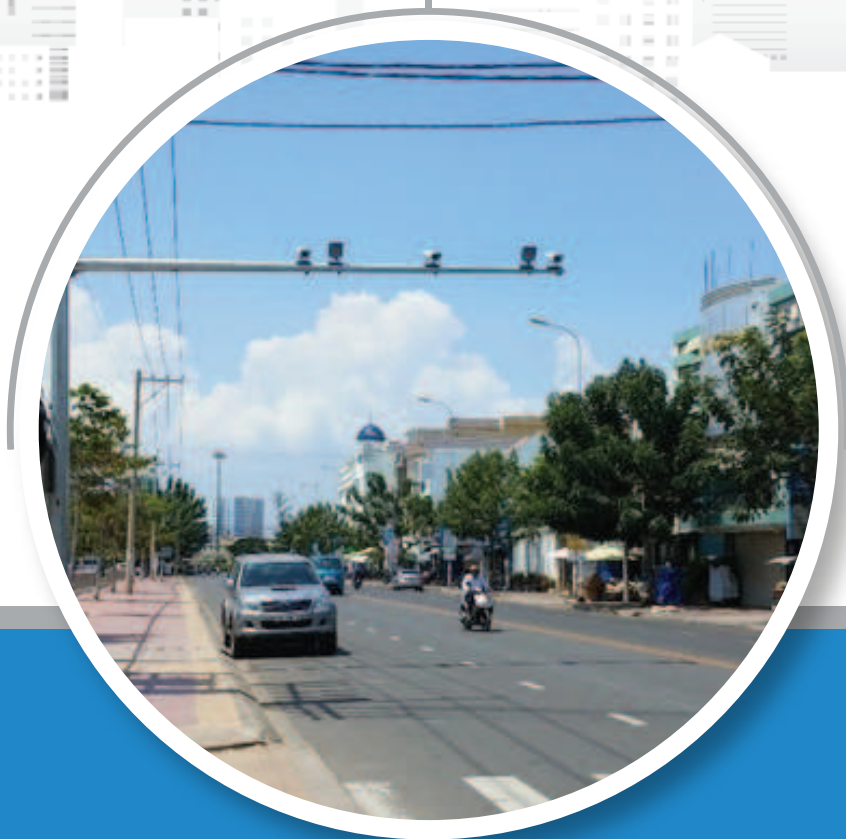
Lắp đặt 29 điểm Camera An ninh trên địa bàn Thành phố Bắc Giang
