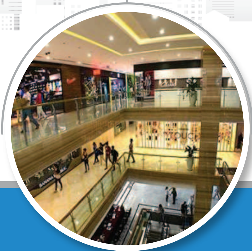
Lắp đặt hệ thống camera giám sát TTTM Vincom Center Bà Triệu
