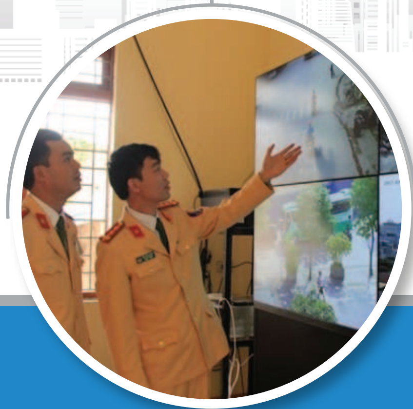
Lắp đặt camera giám sát an ninh trên địa bàn huyện Tân Yên, tỉnh Bắc Giang
