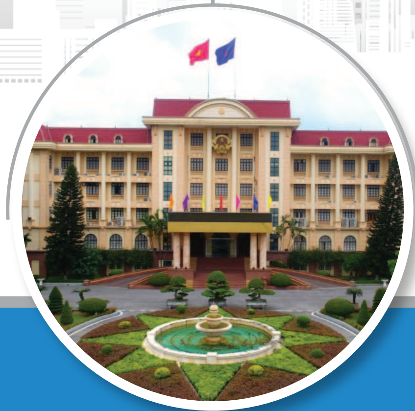
Thi công hệ thống mạng, thoại, truyền hình, camera, âm thanh loan báo khối liên cơ quan UBND TP Bắc Giang
